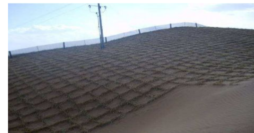
사진 4. 사막화 방지를 위해 격자모양으로 박은 보릿짚 ( http://wenku.baidu.com/view/2ce6242f7375a417866f8fd6.html )
